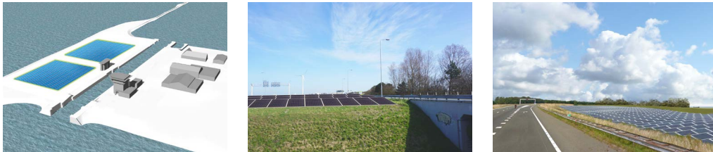
Afbeelding 8: voorbeelden van inpassing knooppunt Den Oever: terrein schutsluis (links), strook tussen de rijbanen (midden), tussen A7 en de Wieringerzeedijk (rechts)
